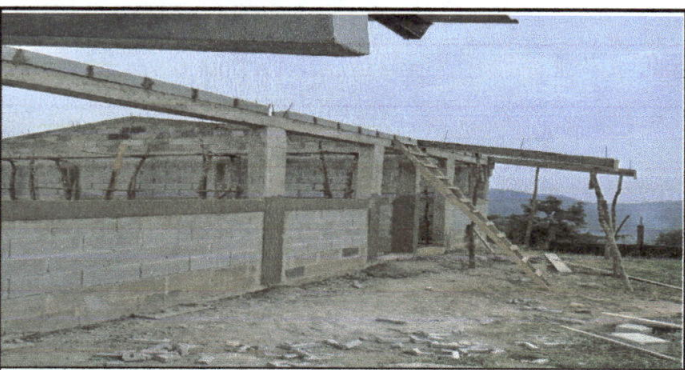
Foto 5: Trabajo de entechado del nuevo aula.
