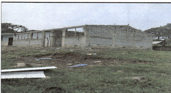
Foto 4: Terminación de solera superior.
