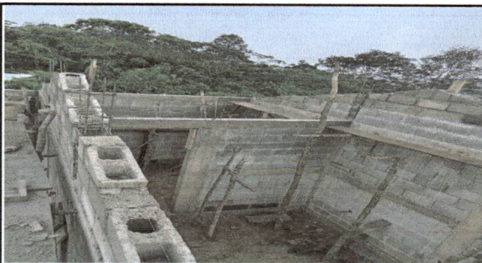
Foto 3: Inicio del trabajo para solera superior del nuevo aula, bodega y dirección.
