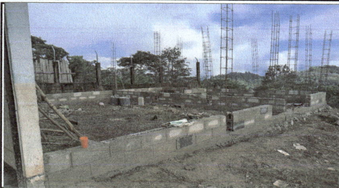
Foto 1: Inicio de trabajo de paredes del nuevo aula.
